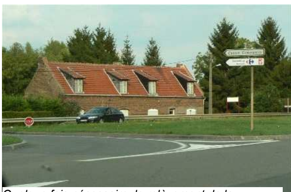
Quelque fois nécessaire, le relèvement de la chaussée n'est pas sans inconvénient pour les riverains, ni pour l'esthétique
